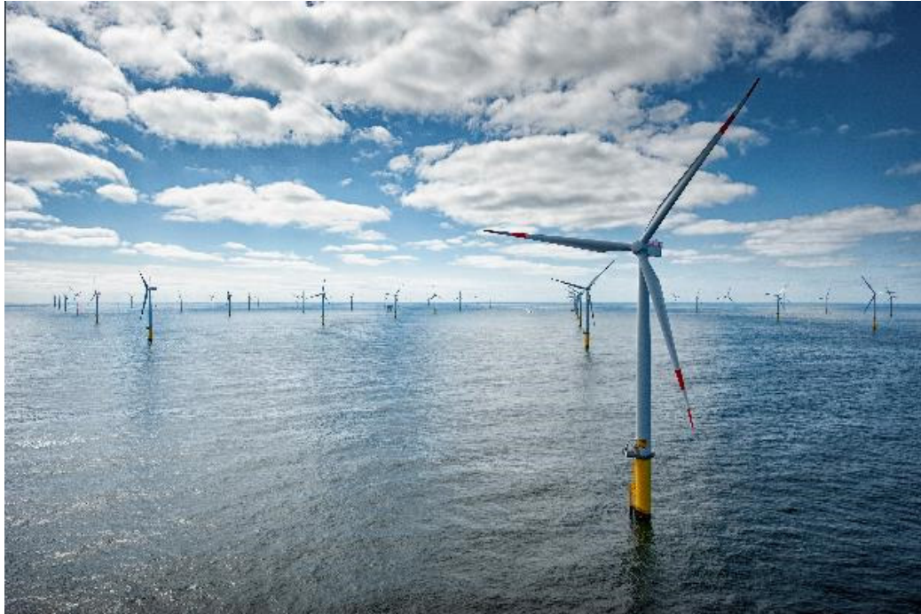
Bild (Download hier ): Windkraftanlagen im Offshore-Windpark Borkum Riffgrund 1, in dessen Nähe der Bau von Borkum Riffgrund 3 geplant ist. (© Ørsted / M.Ibeler)
